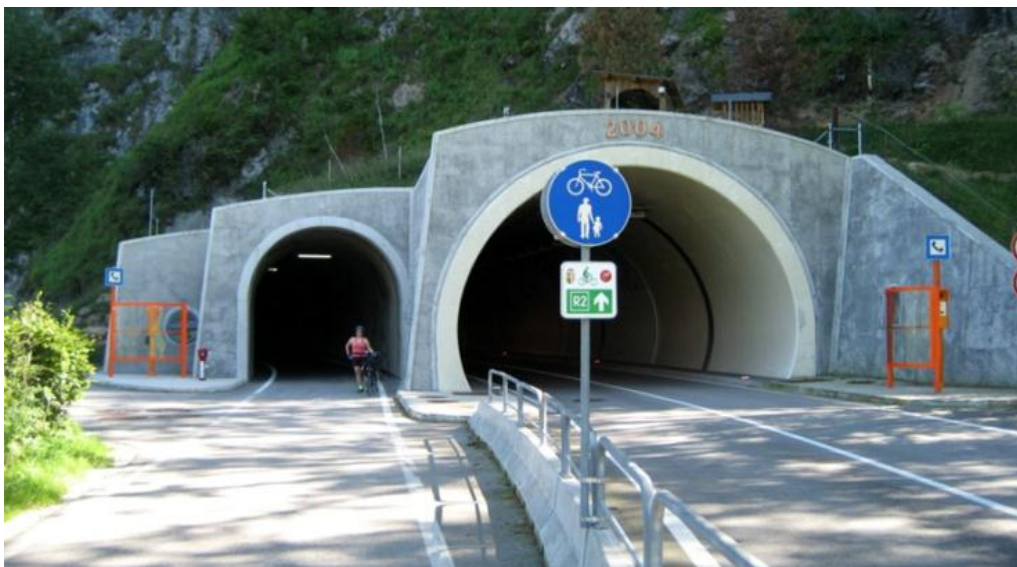
Figur 8 Sykkeltunnel i Salzburg
